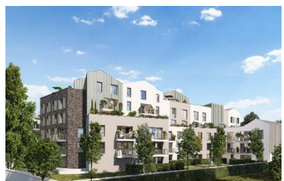
Façade côté jardins intérieurs
