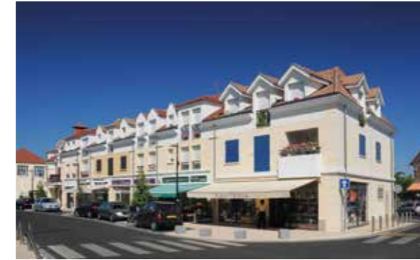
Les Allées Saint-Rémy - Draveil Architecte : Cabinet Elleboode
