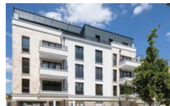
Villa Flora - Fontenay-sous-Bois Architecte : A2D Architecture
